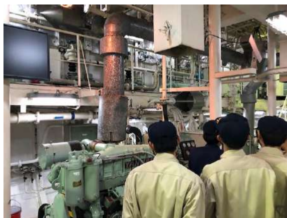
「若潮丸」の機関室で説明を受けている様子
