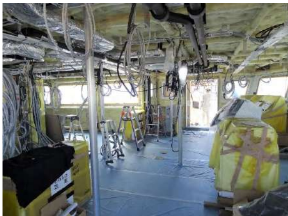
図-4 操舵室防火構造(防熱)
