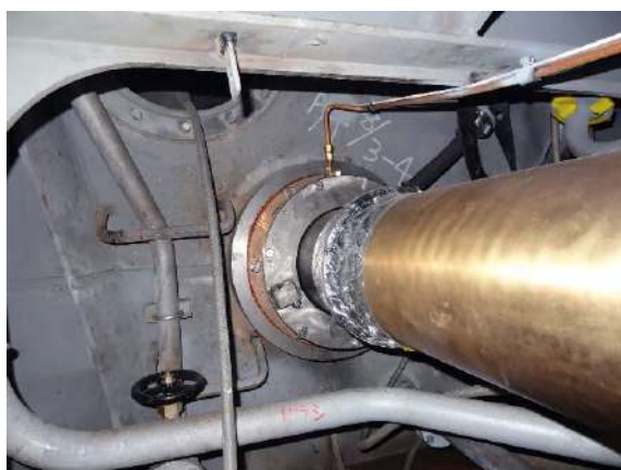
図-6 船尾管軸封装置組み立て完了後
