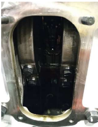
写真 4 軸受温度計測のため開放されたクランクケース
