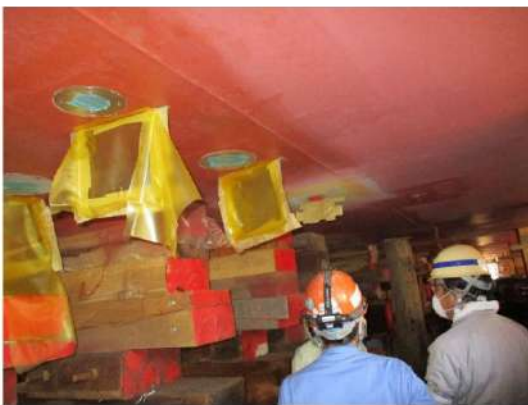
写真2 船底機器取付状況(船底外板外側)
