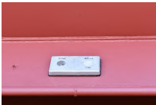
写真2：防蝕亜鉛板
