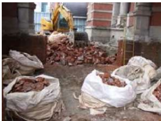
東京駅舎改修工事の廃煉瓦
